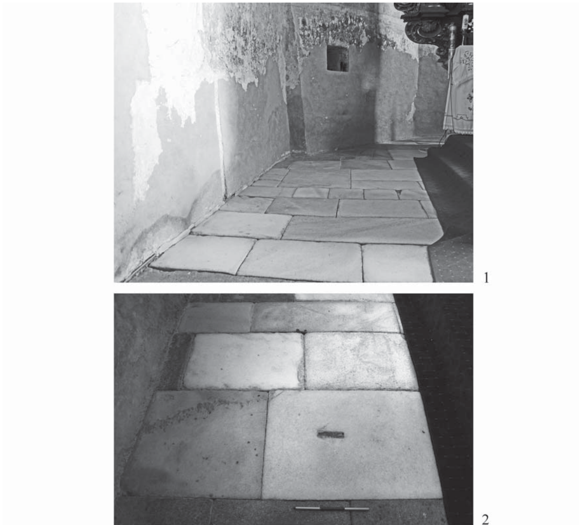
Abb. 2. 1. Innenraum der bestehenden gotischen Kirche (rechte Seite des Chorraums) mit den Resten der vorromanischen Apsis und den weißen Marmorplatten am Sockel, 2. Innenraum der bestehenden gotischen Kirche (linke Seite des Chorraums). Marmorplatten mit der Vertiefung für die Chorschranke
